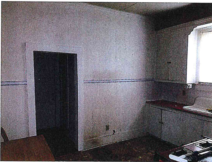
4/19/2016 416 A&B - INTERIOR B SIDE Pic (11).jpg
