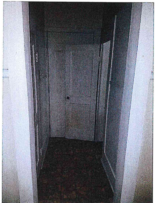
4/19/2016 416 A&B - INTERIOR B SIDE Pic (12).jpg
